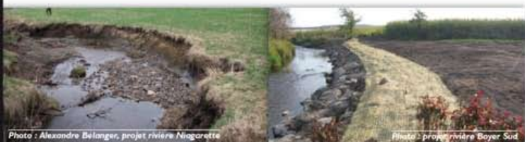
Photo de gauche, berge érodée par la vitesse d'écoulement de l'eau et, photo de droite, berge stabilisée par des travaux d'enrochement au pied du talus et de plantation d'arbustes dans le talus
