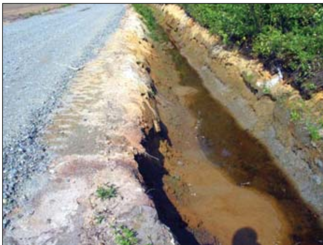
Photo 3 : Phénomène de boulangerie suite au creusage d'un cours dans un sol avec une nappe élevée Source : Victor Savoie, MAPAQ
