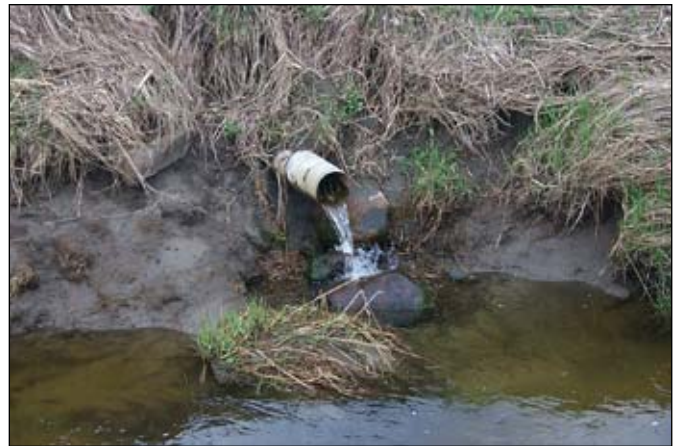
Photo 12 : Érosion à la sortie d'un drain Source : Mikael Guillou, MAPAQ
