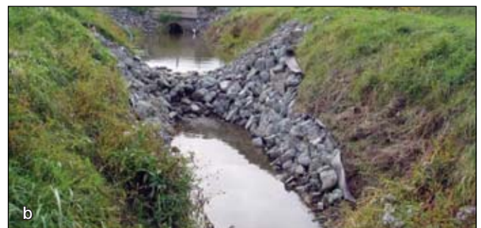
Photos 7 (a et b) : Seuils dissipateurs d'énergie Source : Jacques Goulet et Victor Savoie, MAPAQ
