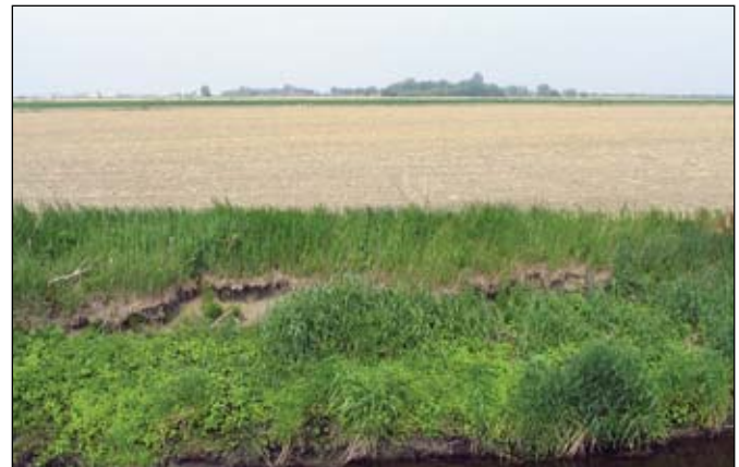
Photo 15 : Glissement de la berge Source : Robert Beaulieu, MAPAQ
