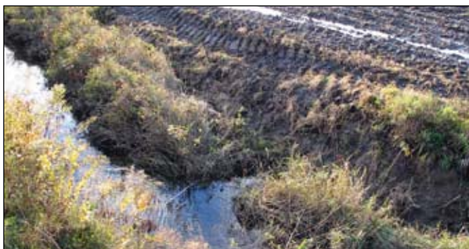
Photo 17 : Glissement suite à une charge excessive Source : Mikael Guillou, MAPAQ
